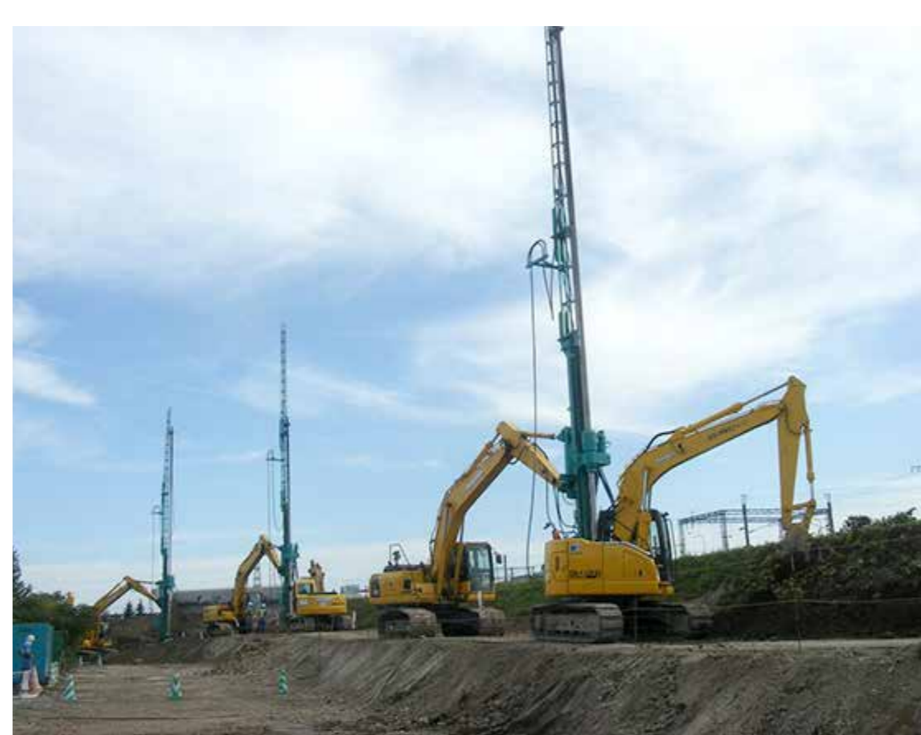
市街地施工 SF-200LSHタイプ
